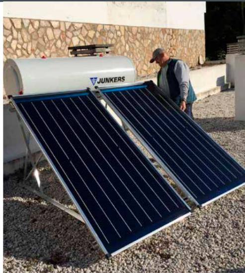
tán Formados por uno o dos captadores solares, estructura de aluminio o acero, depósito de acumulación y accesorios de conexión flexible. Su principal ventaja es que el captador solar calienta el agua del circuito cerrado y esta, a su vez, calienta el agua sanitaria, gracias al depósito de doble envolvente, por lo que su instalación es muy sencilla al no precisar de bomba para poner esa agua en movimiento.
